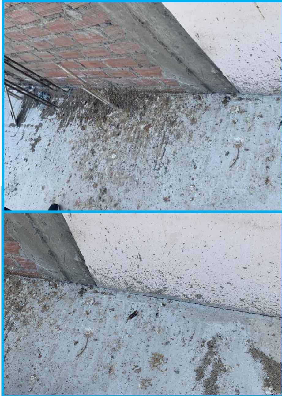
Figura N° 04: En la vivienda de construcción informal, X-7
