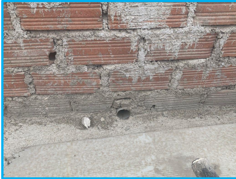
Figura N° 06: En la vivienda de construcción informal X-2
