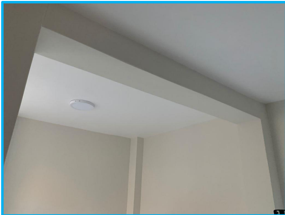
Figura N° 09: En la vivienda de construcción formal X-15
