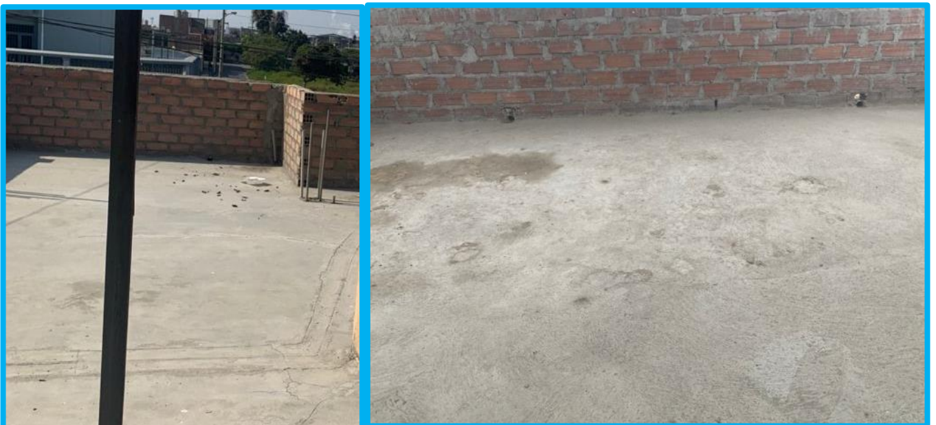
Figura N° 07: En la vivienda de construcción informal X-2
