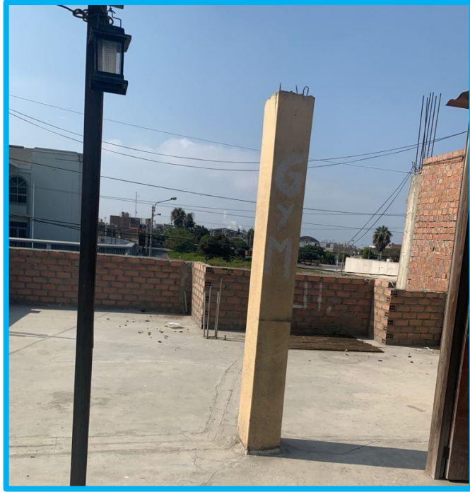
Figura N° 08: En la vivienda de construcción informal X-7
