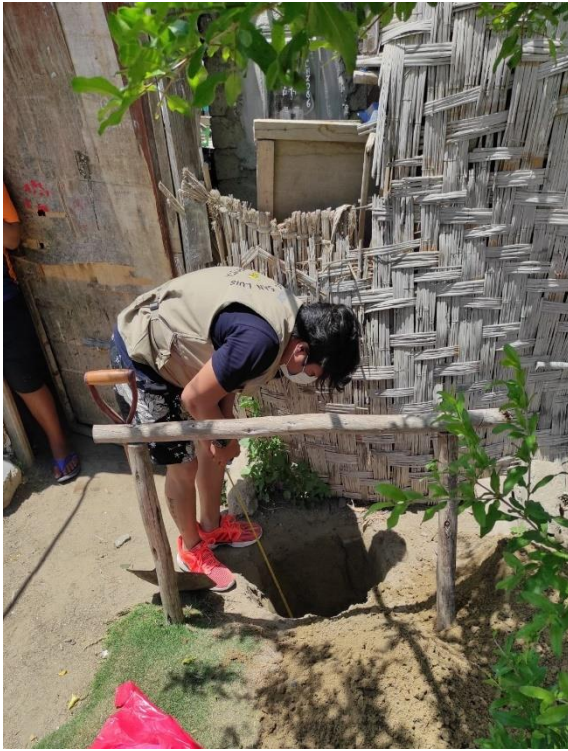
FOTO N°3: EXCAVACIÓN DE LA CALICATA 1 EN EL A.H. NUEVO HORIZONTE A UNA PROF. DE 1.50 M.
