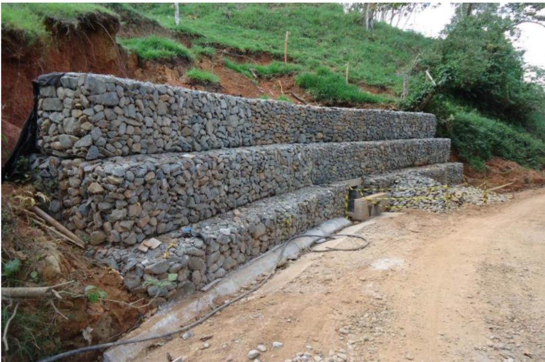
*Figura 1:* Estabilidad del terreno con Gaviones tipo Caja. (Cueva del Ingeniero Civil, s.f.)
