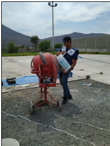
Fotografía 31. Proceso de mezclado de los componentes del concreto en la mezcladora.
