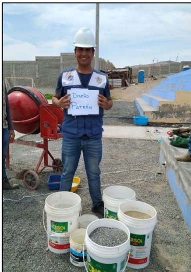
Fotografía 27. Pesaje para los 09 ladrillos patrón a realizar.
