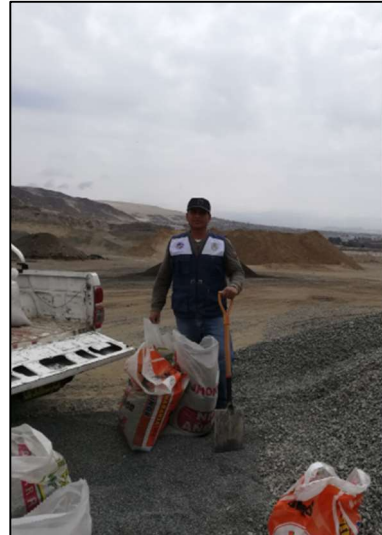
Fotografía 2. Obtención del agregado grueso.
