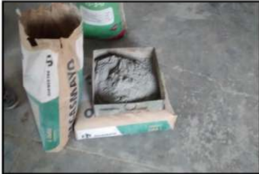
FOTO N° 13: Pesado del cemento para elaboración del concreto.
