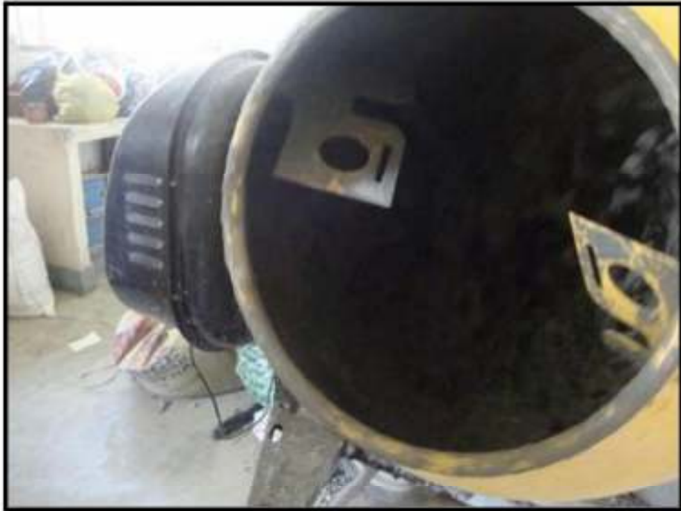
FOTO N° 19: Elaboración de la mezcla de concreto
