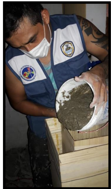
Figura N° 17 - Vaciado de concreto
