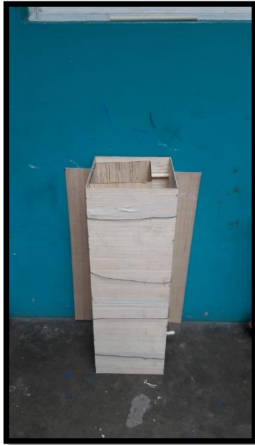
Figura N° 15 - Encofrado acabado
