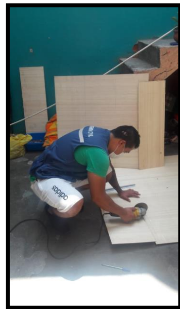
Figura N° 14 - Cortando el triplay
