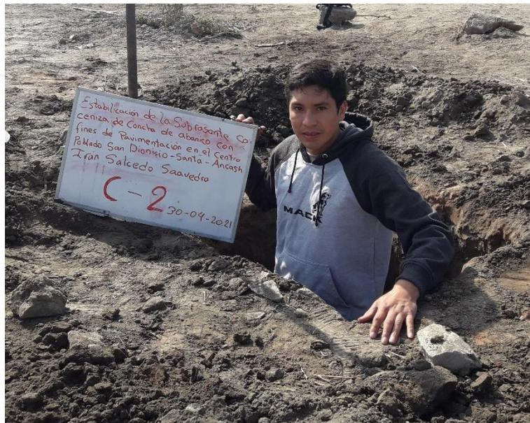
**Foto 5:** Excavación de calicata N° 02, ejecutada por el tesista hasta una profundidad de 1.50 m
