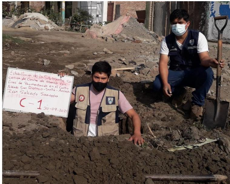
**Foto 3:** Excavación de calicata N° 01, con la supervisión del personal de Laboratorio de Ensayo de Materiales de la USP
