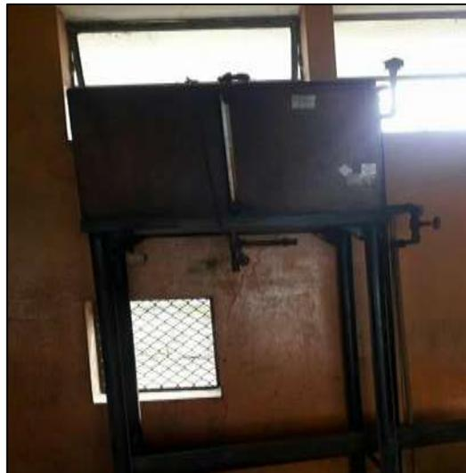
**Figura 12.-** Fotografía Equipo Tanque de metal para almacenamiento de combustible del Caldero.
