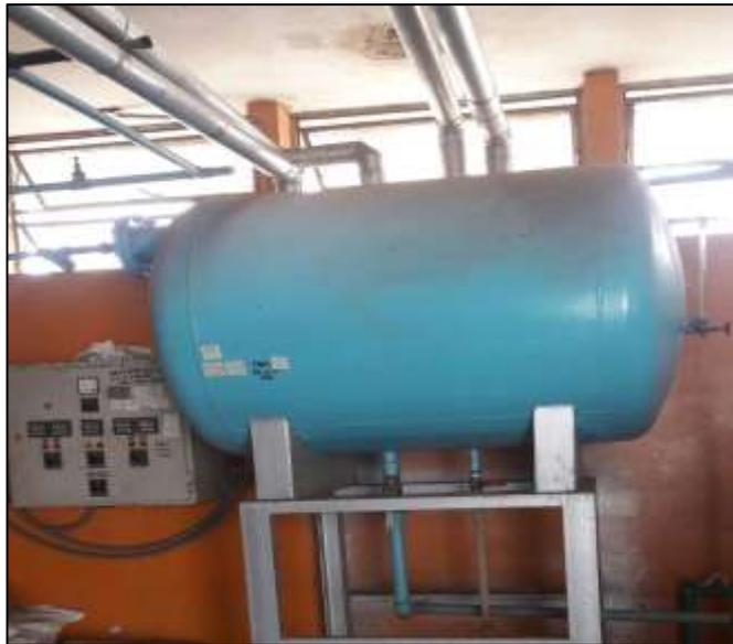
**Figura 10.-** Fotografía equipo tanque de condensado.
