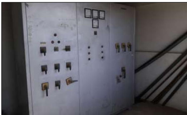
**Figura 6.-** Fotografía del equipo Banco de condensadores.
