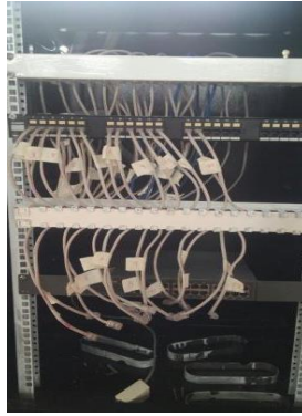
Figura 38. Colocación de los Punto al Pach Panel el gabinete principal.
