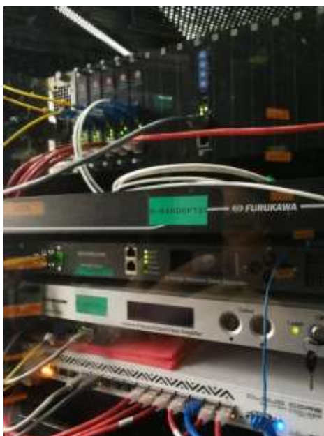
Figura 30: Instalación de ODF - Jr. Gálvez N° 587 – Barranca.
