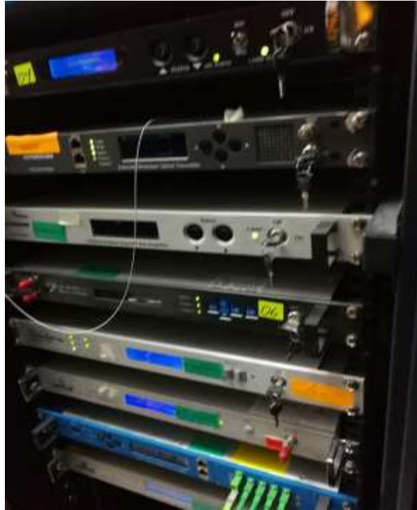
Figura 33: Instalación de ODF - Jr. Gálvez N° 587 – Barranca. Origen: Recurso propio.
