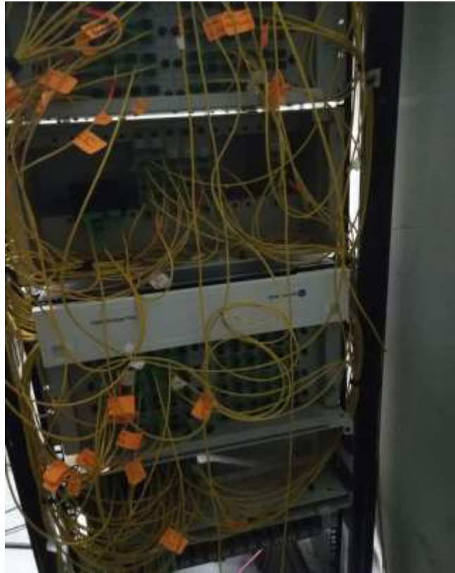
Figura 31: Instalación de ODF - Jr. Gálvez N° 587 – Barranca. Origen: Recurso propio.
