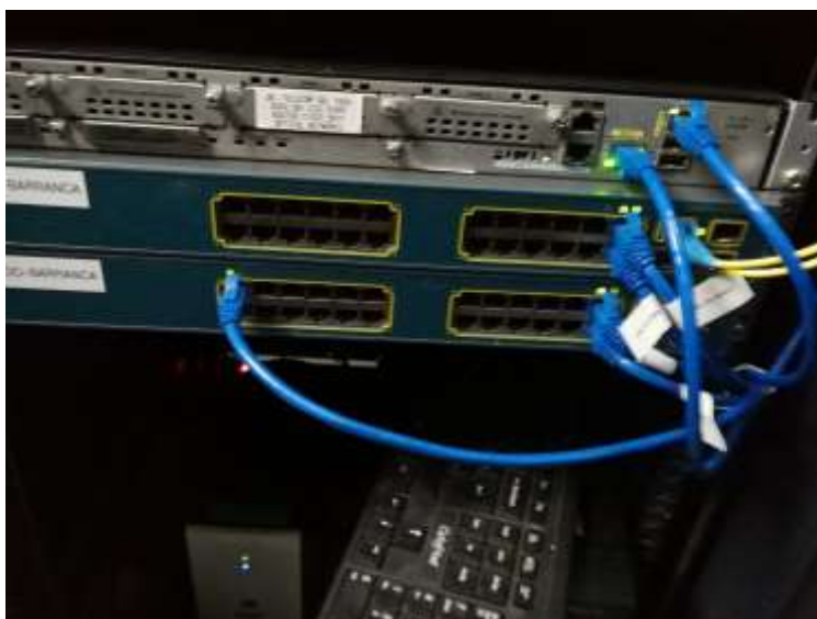
Figura 29: Instalación de ODF - Jr. Gálvez N° 587 – Barranca.
