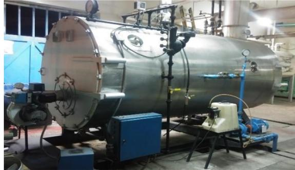
Figura N° 14. Esquema de Caldera Piro-tubular Intesa N°01
