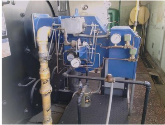
*Figura N° 24.* Conjunto de Control de Combustible al Quemador
