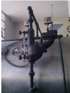
*Figura N° 21. Medidor de Nivel de Agua*
