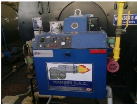
*Figura N° 22. Conjunto de Ignición Automática*
