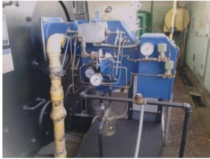
*Figura N° 20.* Quemador de Combustible Manser
