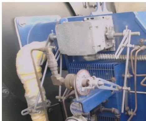
*Figura N° 25.* Motor Modulador de Registro.
