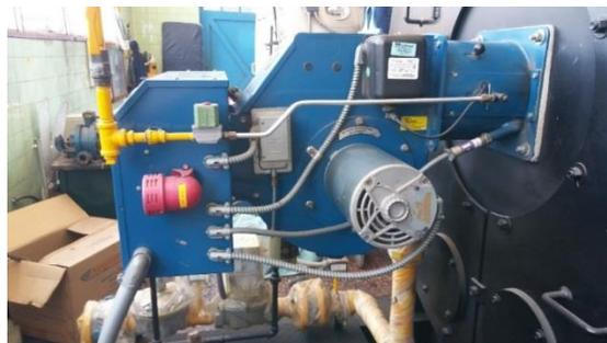
*Figura N° 16. Motor generador de aire*
