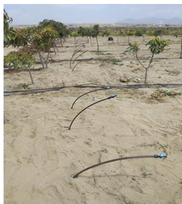
Figura 4. Instalación del riego tecnificado del campo experimental
