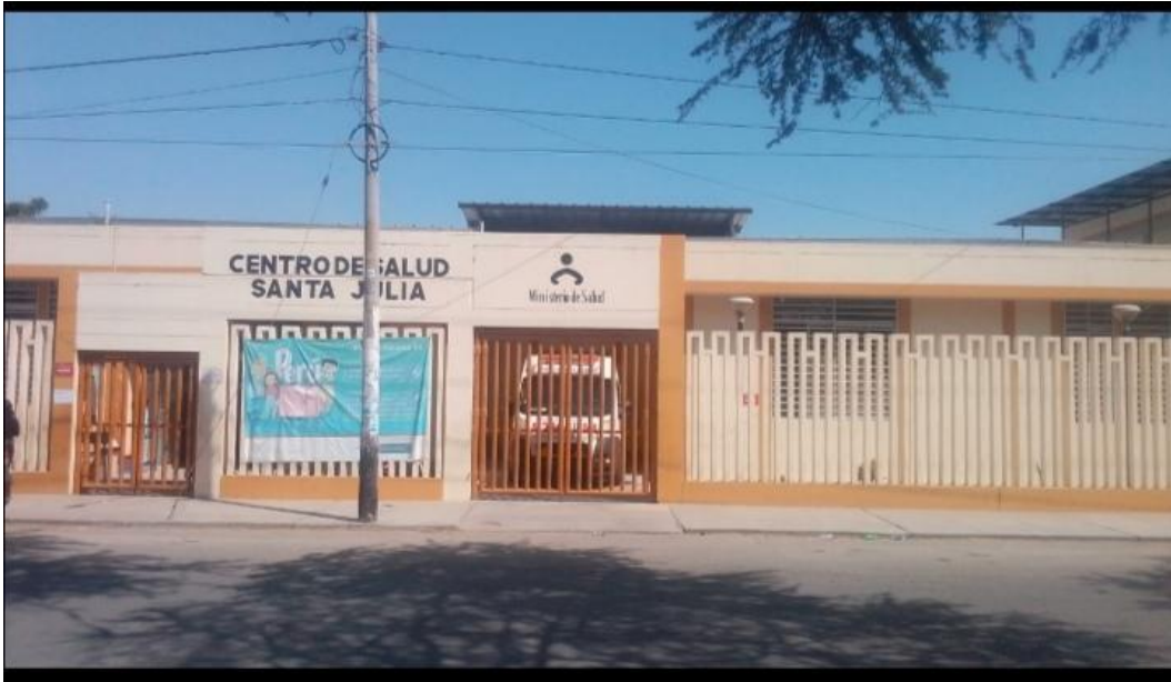
Foto 1 : Frontis de Centro de salud de Santa Julia .AH Santa Julia . Piura Piura 2019
