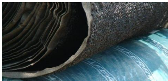
Figura 103: Filtro de cubierta verde en Edificio real 6.
