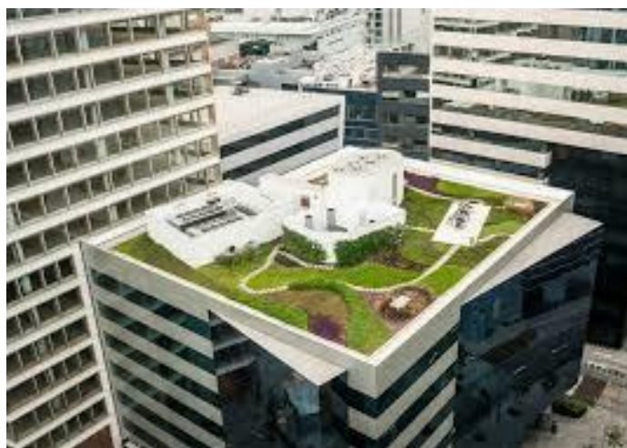
Figura 104: Cubierta verde en Edificio real 6
