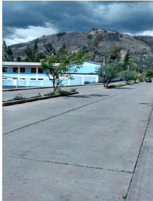
Figura 11: Av. Santa Teresa Fuente: Evidencia fotográfica Fecha: 2019
