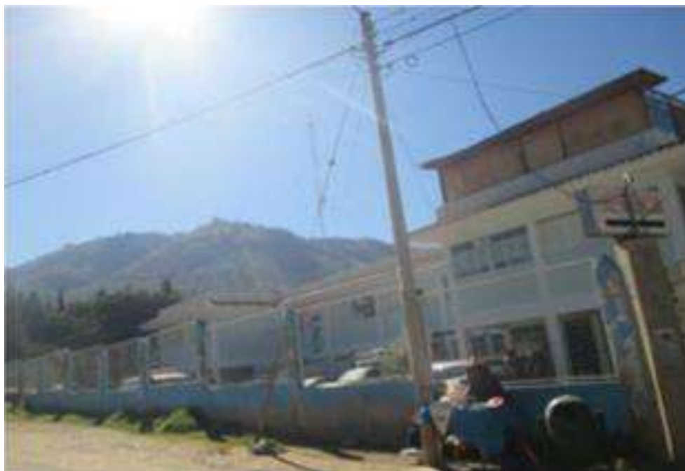
Figura 18: Centro de Salud Fuente: Evidencia fotográfica Fecha: 2019
