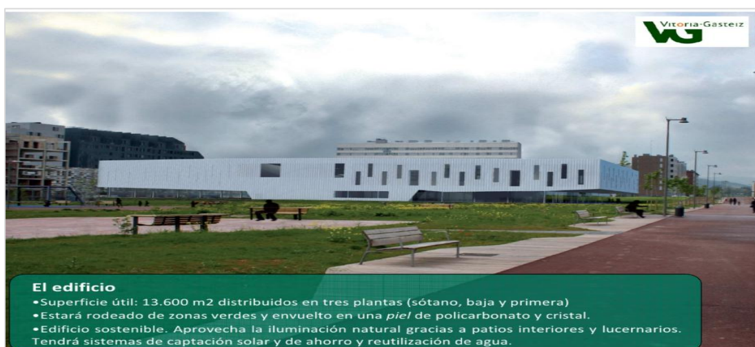
Figura 20. Foto de los espacios del centro cívico de Salburúa
