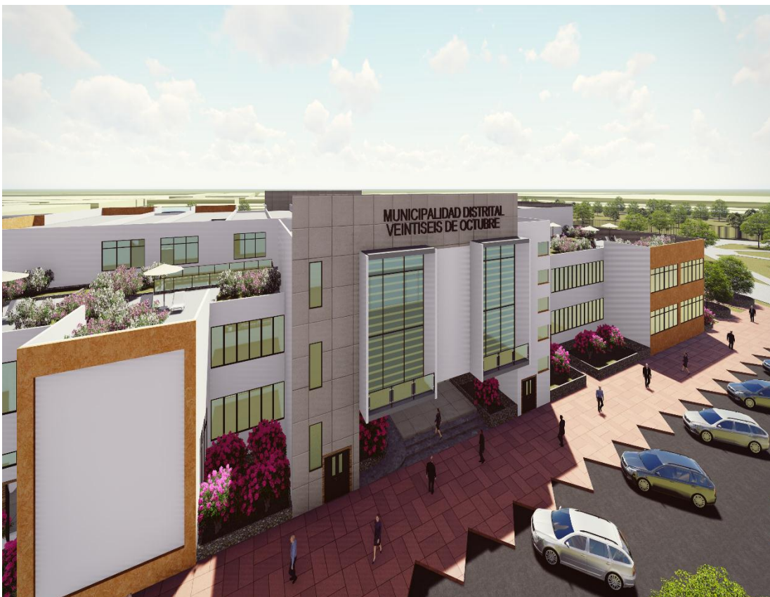
Figura 31. Vista 2 de Fachada exterior de la parte delantera del centro civico
