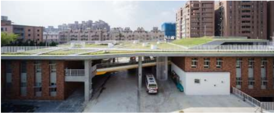
Figura 32: Fotografía frontal de la estación de bomberos Fuente: página web www.archdaily.pe
