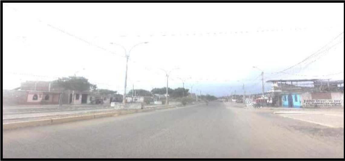
Figura 20. Vía principal de ingreso asfaltada Tomado de: Elaboración Propia
