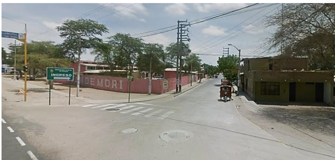
Figura 7. Subestación de energía eléctrica Fuente: Elaboración propia Año: 2019
