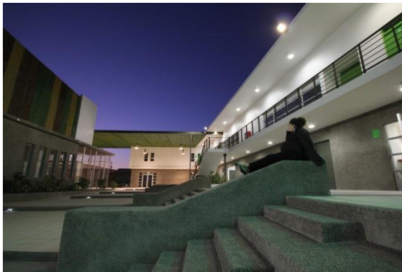
Figura 56. Patio Central - Centro Cultural Alto Hospicio Fuente: Archdaily Año: 2019
