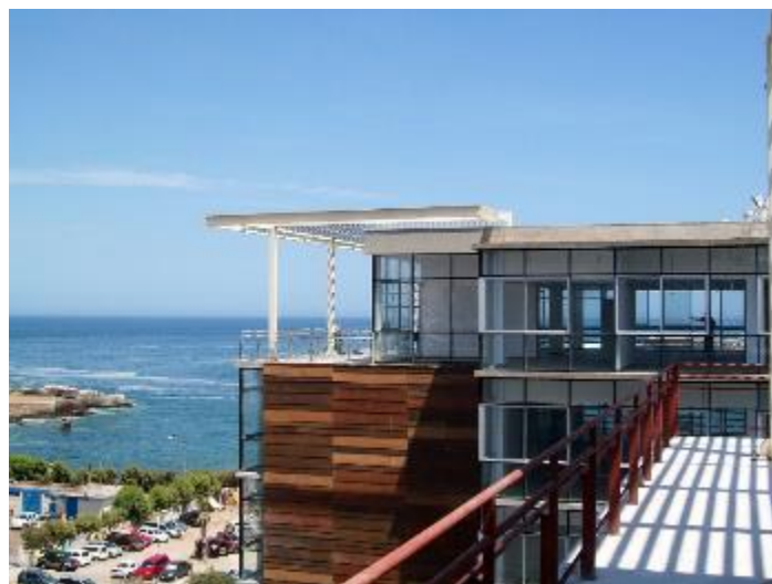
Figura 24: Edificio Consistorial de la municipalidad Fuente: Elaboración propia Año: 2019
