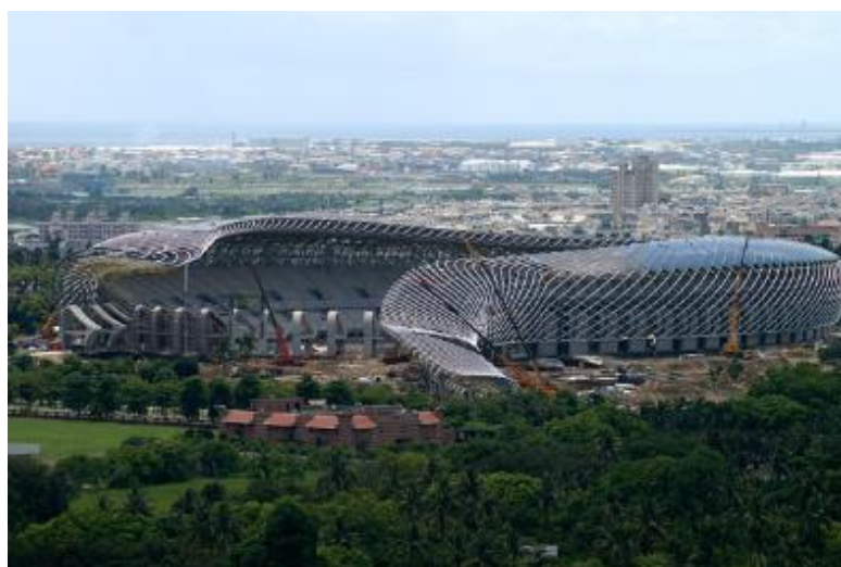
Figura 28: Estadio nacional de Kaohsiung - paneles solares Fuente: Archdaily.pe Año: 2019
