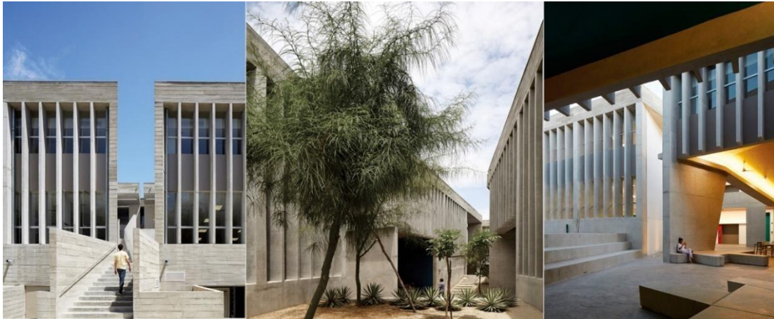
Figura 15. Exterior Aulario UDEP.
