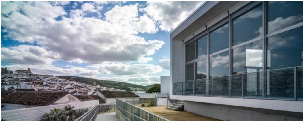
Figura 9: Fachada del Centro de día de mayores en Baena Fuente: arquitecturacontemporanea.org/cordova/portfolio/centro-de-dia-baena/ Año: 2015
