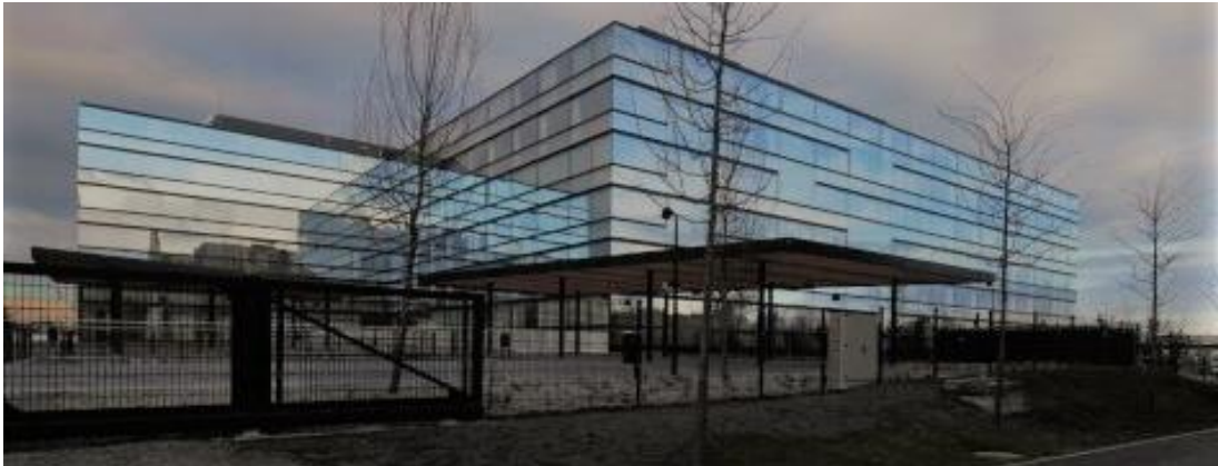
Figura 10: Vista Frontal del Centro Geriátrico Donaustadt Viena
