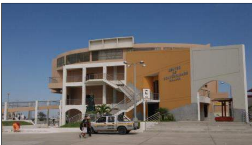
Figura 3. Centro de Convenciones, sin el uso adecuado. Fuente: Propia
